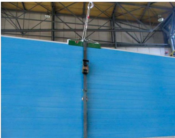
Фото № 8. Использование подъемного монтажного инструмента для сэндвич-панелей при размещении в горизонтальном положении.
