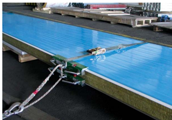
Фото № 5. Подъемный монтажный инструмент для сэндвич-панелей Ruukki при размещении в вертикальном положении.
