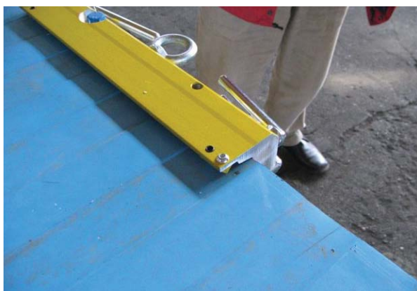
Фото № 6. Подъемный монтажный инструмент для сэндвич-панелей Ruukki при размещении в вертикальном положении.
